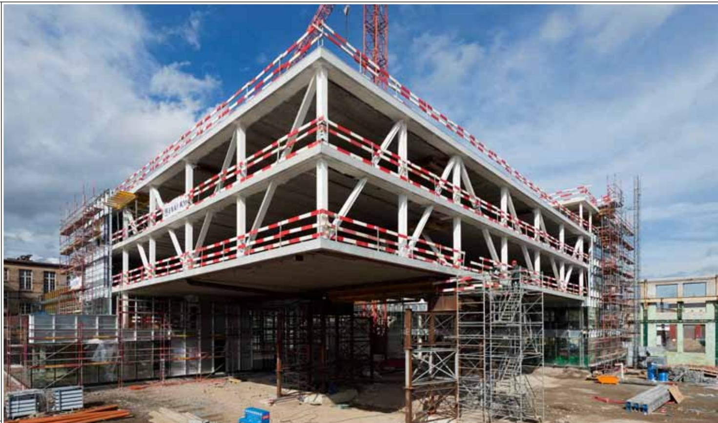
verdiepingen. Ze bestaat uit vier vakwerkliggers met een overspanning van 25 à 35 m die elkaar ondersteunen en waarvan de grootste ingeklemd zit in een indrukwekkende nagespannen betonnen console die rechtstreeks op het 10 m dieper rotsgesteente rust. Door zijn zeer grote stijfheid en weerstand, zorgt staal ervoor dat het geheel bijzonder licht oogt, ondanks de aanzienlijke massa van 2 000 ton die de oversteek vertegenwoordigt.
